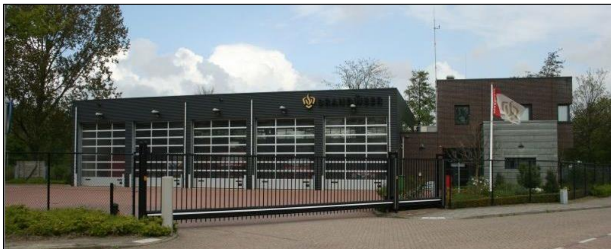
Figuur 7 - Brandweerpost Vlissingen- Olympiaweg, waar een dagbezetting voorzien is.
